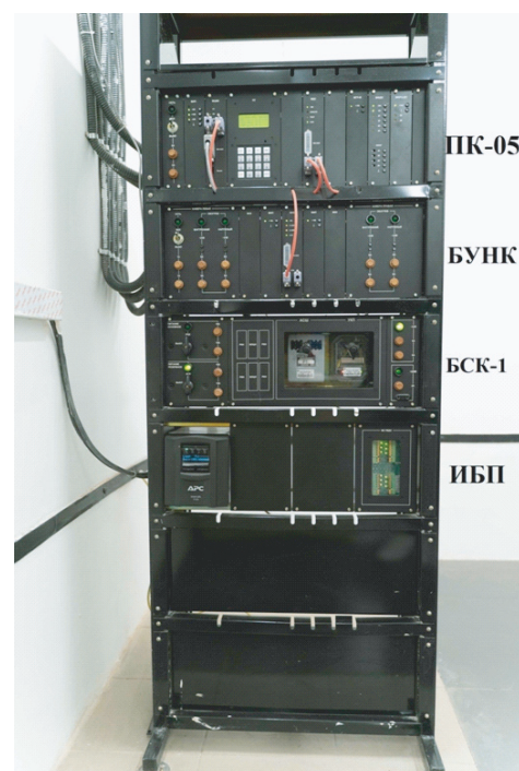
Рис. 4. Станционная стойка КТСМ-02: ПК-05 – блок базовый; БУНК – блок управления напольными камерами; БСК-1 – блок силовой и коммутационный; ИБП – источник бесперебойного питания
