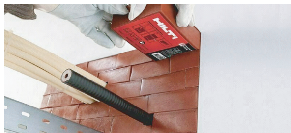
Рис. 4. Заделка с применением пеноблоков и герметизирующего состава
