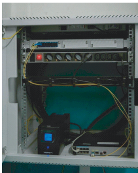
Рис. 2. Коммутационный шкаф
