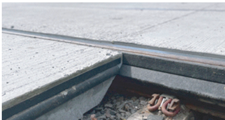
Рис. 1. Пример конструкции безбалластного пути для городского транспорта
