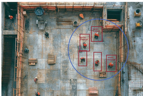
Рис. 1. Строительные работы под подъемным механизмом крана
