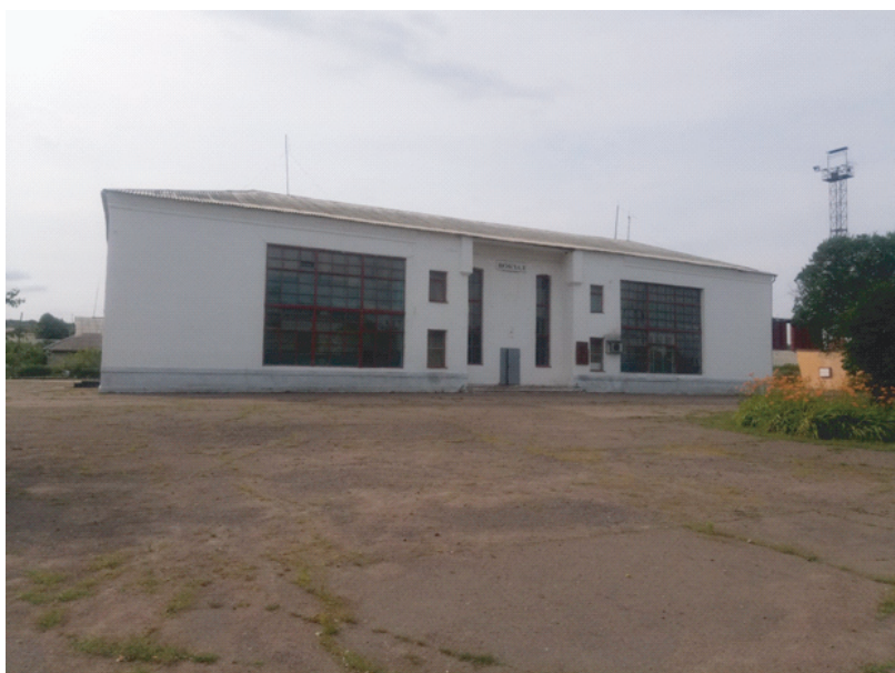
Рис. 2. Здание вокзала на станции Калач
