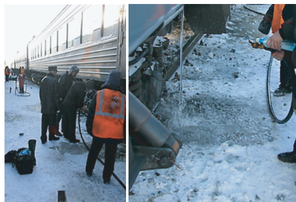
Рис. 10. Поточная обработка систем водотеплоснабжения пассажирских вагонов в эксплуатационном депо
