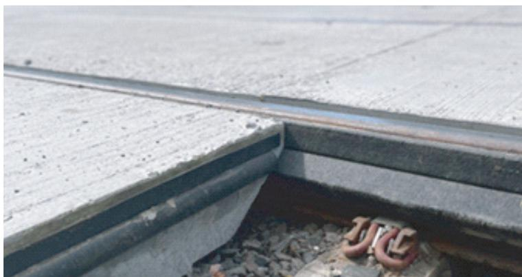
Рис. 1. Пример конструкции безбалластного пути для городского транспорта
