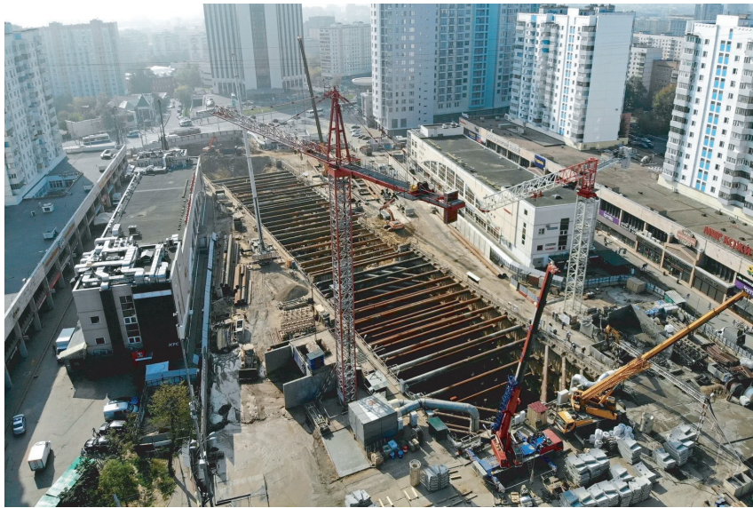
Рис. 1. Пример строительства линии метрополитена в существующей плотной застройке
