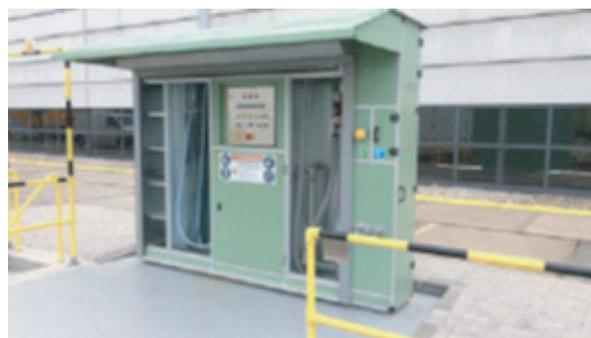
Рис. 2. Мобильная и стационарная установки для откачки сточных вод
