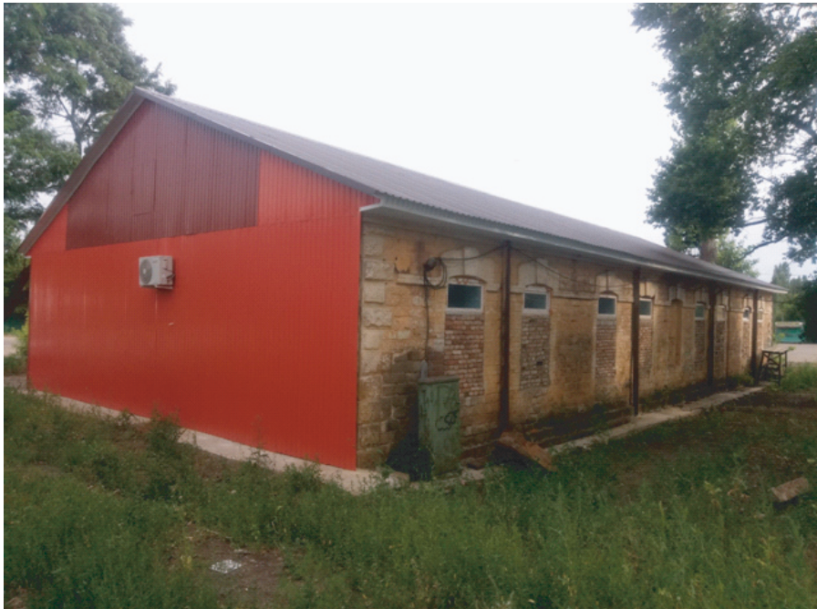
Рис. 3. Станционная постройка на станции Калач
