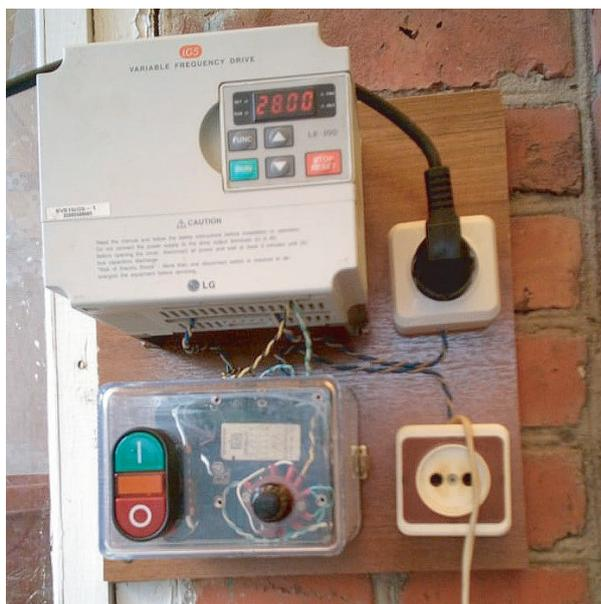
Рис. 2. Внешний вид установленного блока управления насосом
