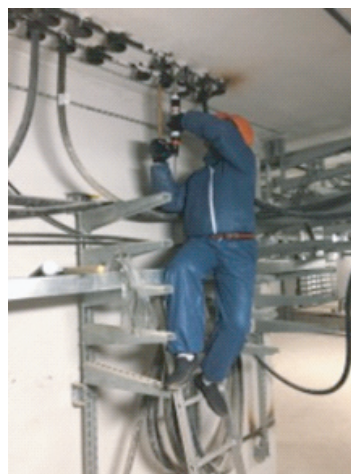
Рис. 8. Технология заделки проема системой Ферум-Пласт
