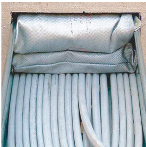
Рис. 3. Заделка с применением подушек
