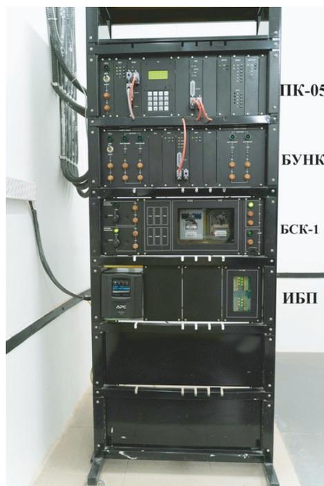
Рис. 4. Станционная стойка КТСМ-02:
