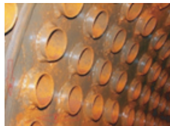
Рис. 1. Состояние водяных трактов котельных через 6–8 месяцев после обработки энергетическим методом:
