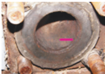
Рис. 1. Состояние водяных трактов котельных через 6–8 месяцев после обработки энергетическим методом:
